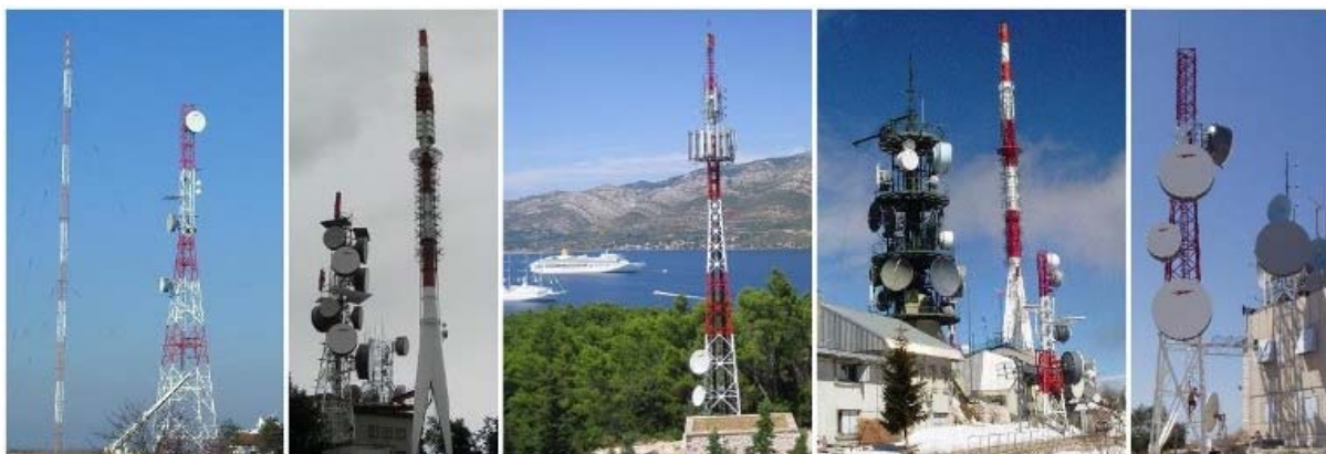
Slika 1.10. Digitalni odašiljači u velikoj mjeri koriste postojeće antenske stupove izgrađene za potrebe televizije ili analognog radija
